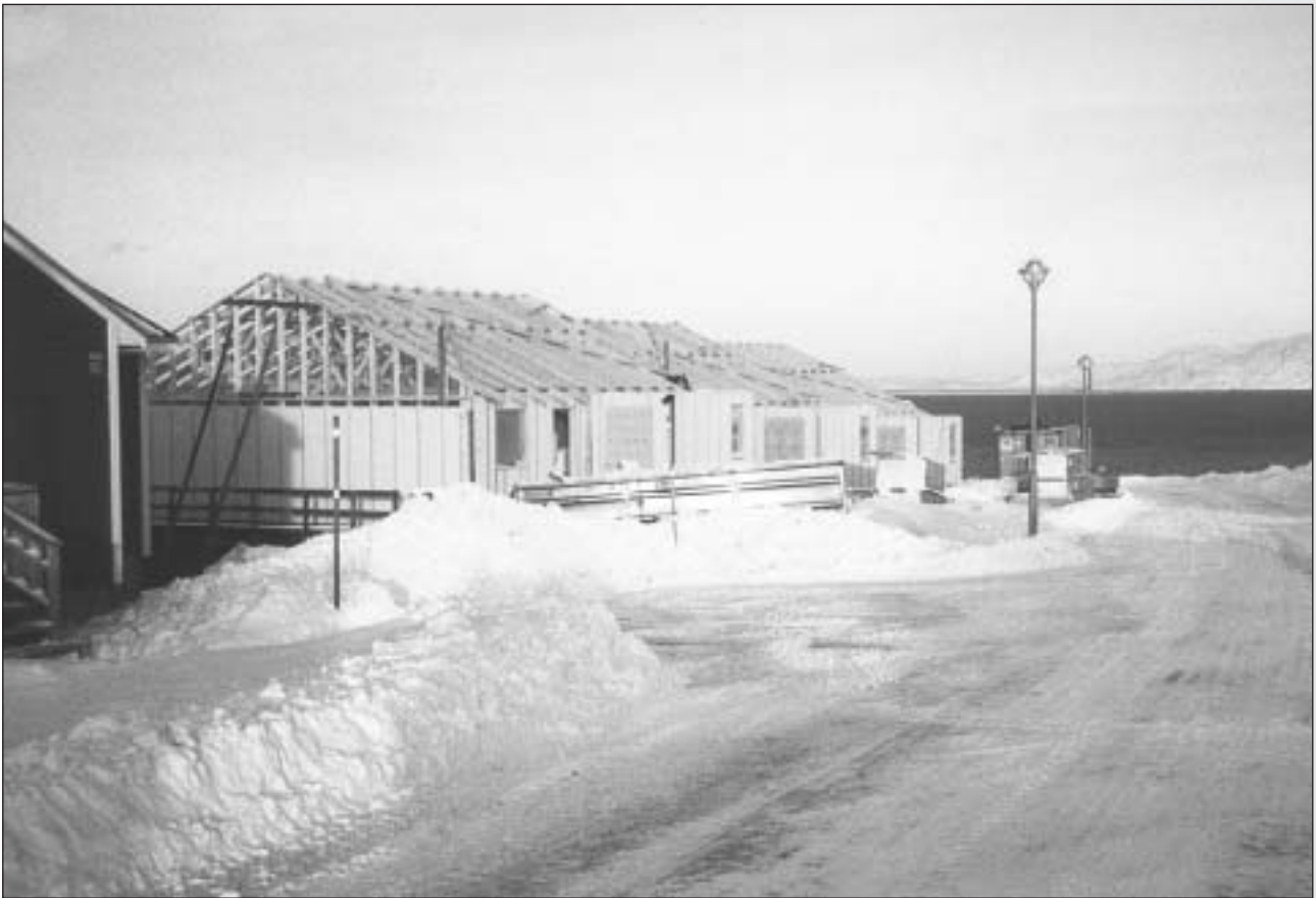
SISA opfører 3 udlejningsboliger i Nuuk 2002/03.
